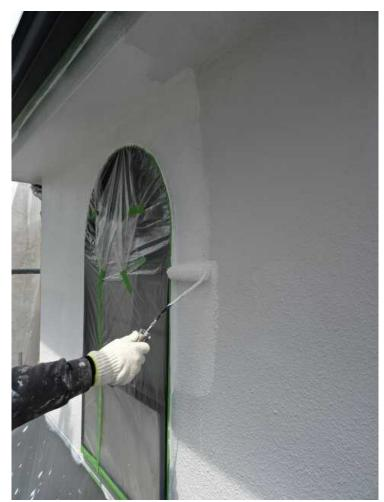
下塗り塗料(ニッペ パーフェクトサーフ)3時間以上の乾燥時間を空けて上塗り工程に入る。 上塗り塗料(ニッペ ハナコレクション100水性)3時間以上の乾燥時間を空けて2回目の上塗りを開始する。
