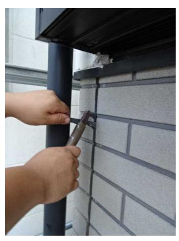
サイデイングの継ぎ目や窓回りのシーリングが経年劣化で「剥がれている」「裂けている」ため、削ぎ落としてシーリングを打ち直します。 サイディングの内側まで「裂けめ」が貫通しているため、高圧洗浄をする前に裂け目から水が浸透しないようにシーリング打ち替え工事を完了しておきます。
