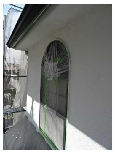
(上塗り工程1回目塗装中・この後2回目を塗装する)
