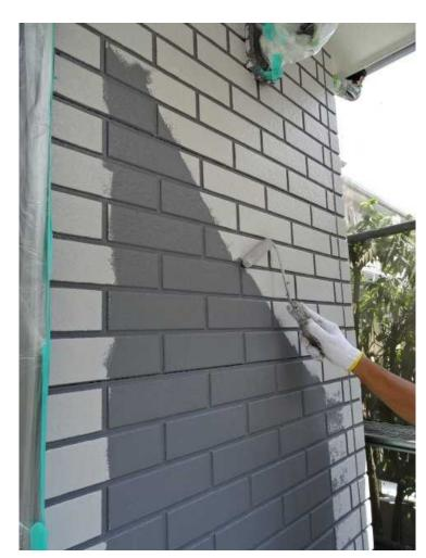
ベルベットのように毛が短い「短毛ローラー」でタイル調表面(凸部)を塗っているところです。 1工程増えるだけでなく、窓の周りや天井面との境目など、ローラーでは塗れない部分は"筆で描く" ことになるため、かなり手間がかかります。
