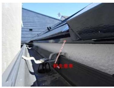
下塗り・ 錆止め塗料(赤さび)1回塗り
