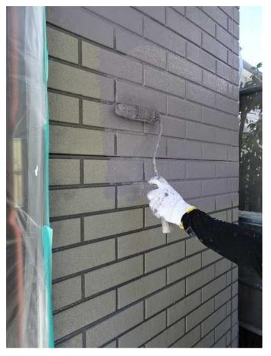
タイル風(タイル調)のサイディングを塗替える場合1色で塗り潰してしまうと「タイル調」ではなくなってしまいますので、2色で塗り分ける方法です。下塗+上塗2回=合計3回塗りして全面をタイル目地(風の凹み)の色で塗り潰して、目地色塗装の仕上がりです。
