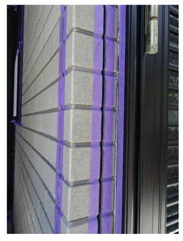
劣化したシーリングの削ぎ落としが終わると、下塗り材(プライマー)を塗る前にテープを貼り、養生します。
